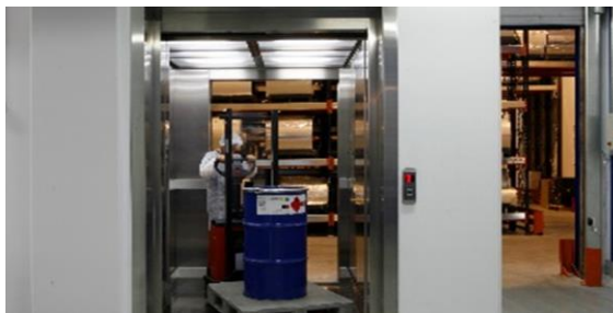
Ascensores de carga
