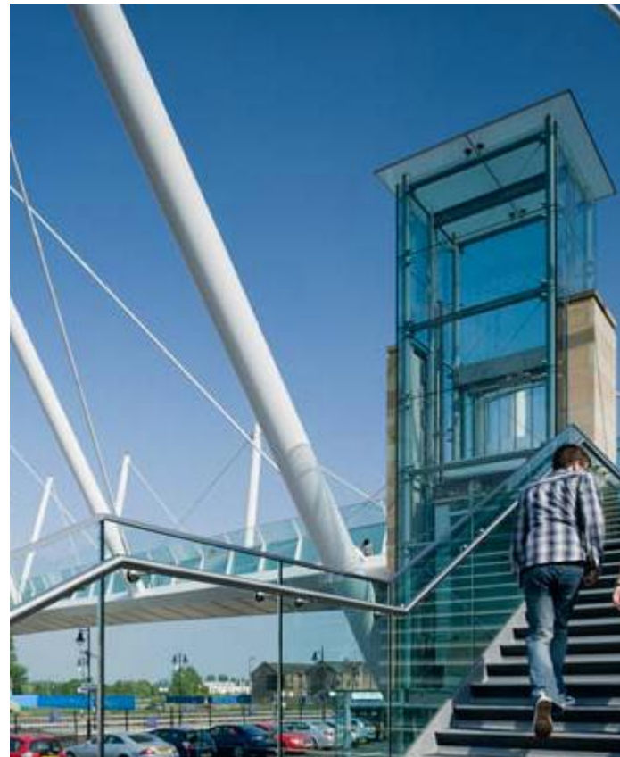
Γέφυρα Στέρλινγκ Στέρλινγκ, Σκωτία
